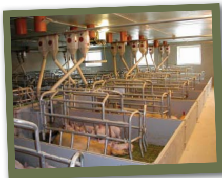
3. ábra Temperált levegő bevezetőcsövek a kocák feje felett a fiaztatóban
