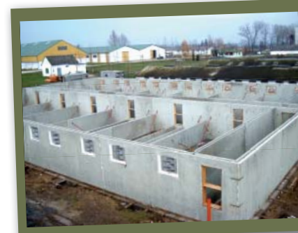
1. ábra Beton kéregpanelekből épülő trágyapincés sertésfiastató
