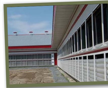
8. ábra Átlátszó anyagú, felfúvással szabályozható magasságú oldalfalról természetes szellőzéshez
